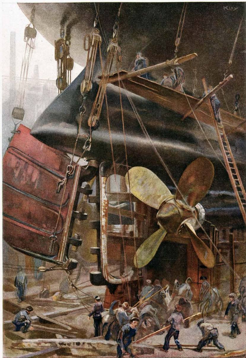
Einsetzen des Ruders auf der Werft
